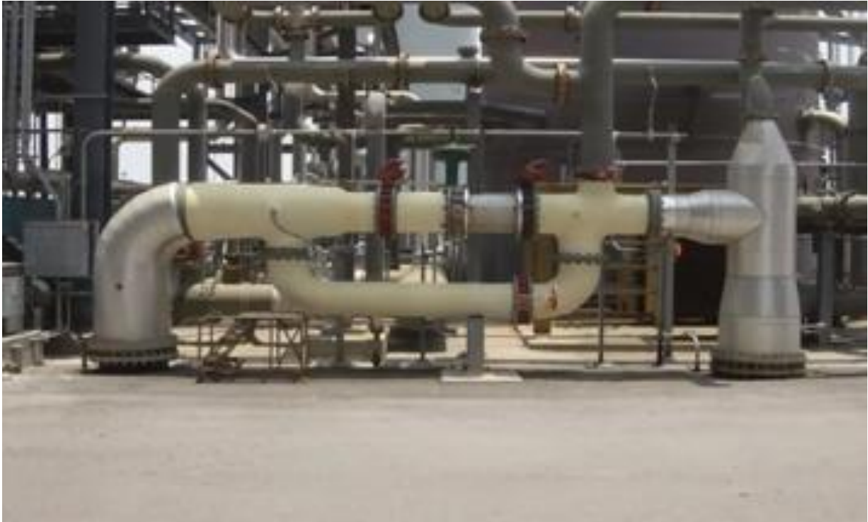
Figura 9 - Reparo de compósito em tubulação com geometrias complexas Fonte: Portal Pipeline Brazil (2022)
