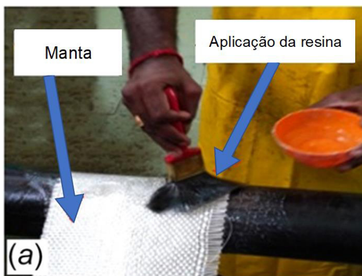
Figura 8 - Aplicação do material compósito Fonte: Khan et al. (2017) (adaptado)
