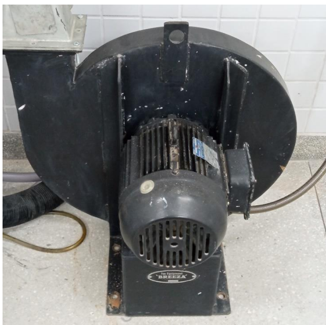
Figura 17: Motor e ventilador do sistema
