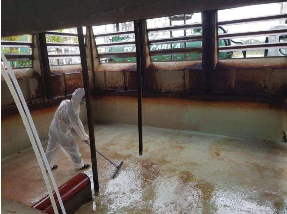
Figura 11: Bacia de uma torre de resfriamento durante uma parada para manutenção.
