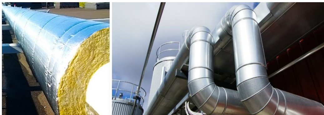
Figura 8 - Aplicação de revestimento externo na tubulação Fonte: Ecotec montagens industriais(2019)
