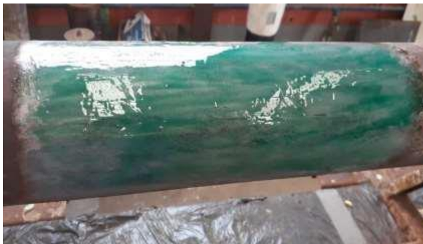
Figura 17 - Aplicação de Camada Primer
