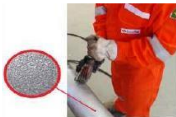
Figura 9 - Preparo de Superfície
