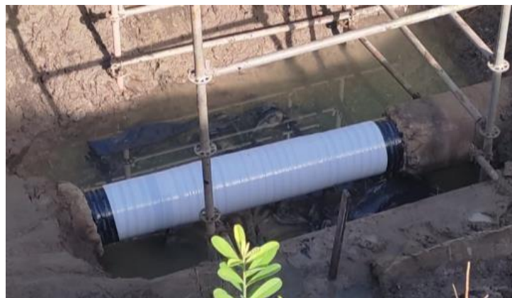
Figura 20 - Aplicação da proteção contra UV
