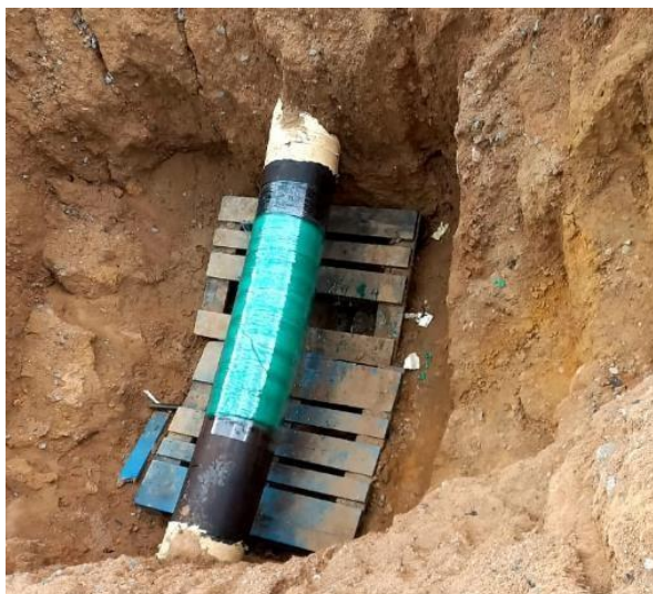
Figura 18 - Envolvimento da Tubulação com Bandagem Impregnada
