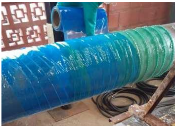
Figura 19 - Aplicação do Filme de Compressão
