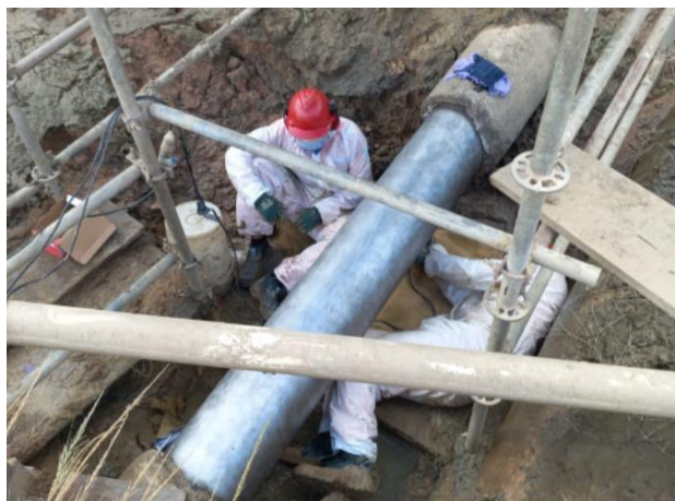
Figura 11 - Suavização da Superfície
