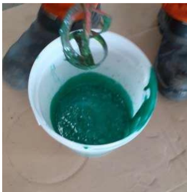
Figura 15 - Mistura da Resina Epóxi e Agente de Cura
