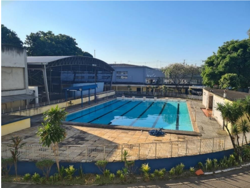
Figura 25: Foto da piscina a partir do sul, vista do 2º andar do bloco D.
